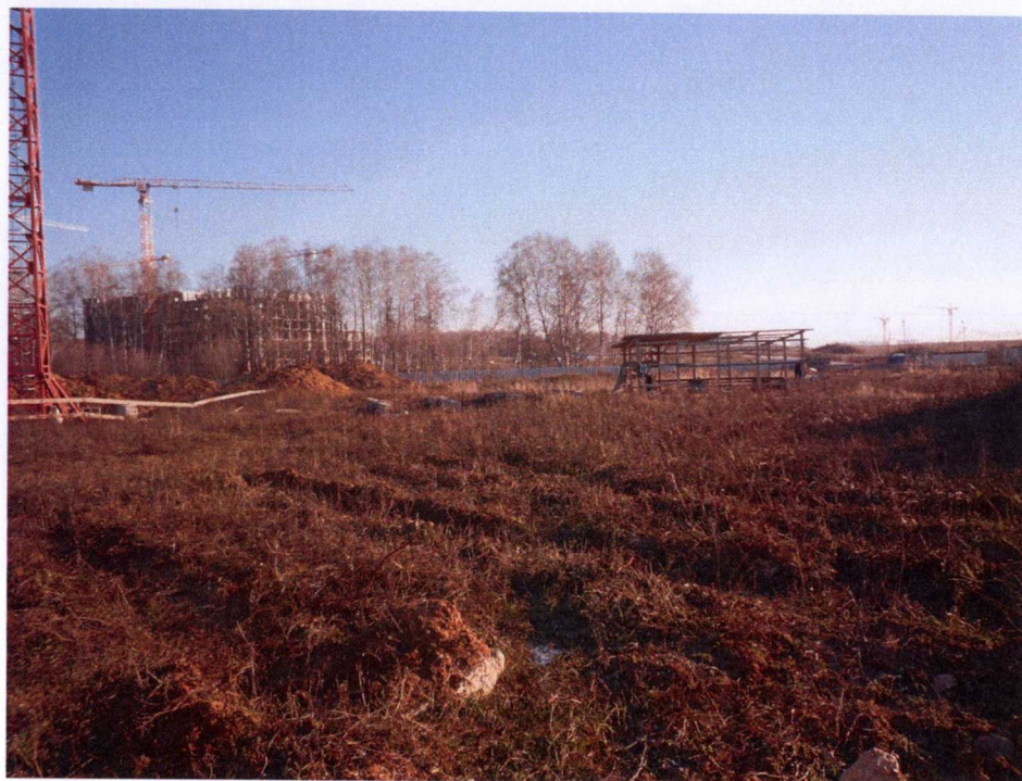
Фото № 6. Площадка под строительство секций 3,4,5.
