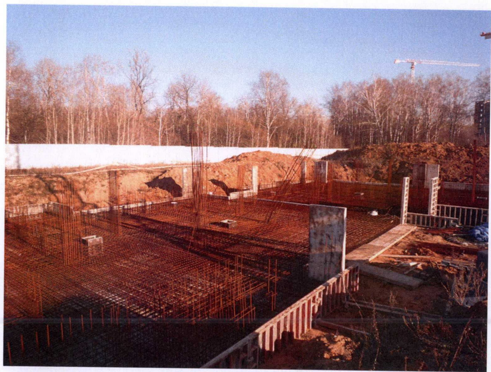
Фото № 1. Общий вид секций 1,2 со стороны дома 63
