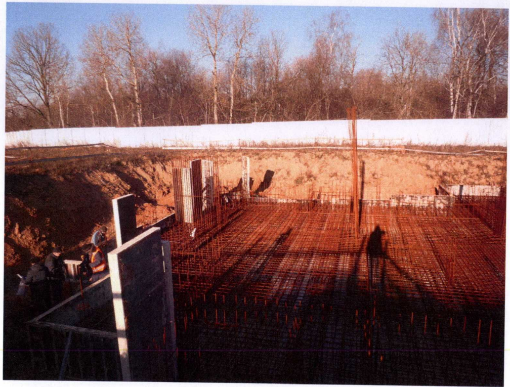
Фото № 2. Арматурный каркас секции 1
