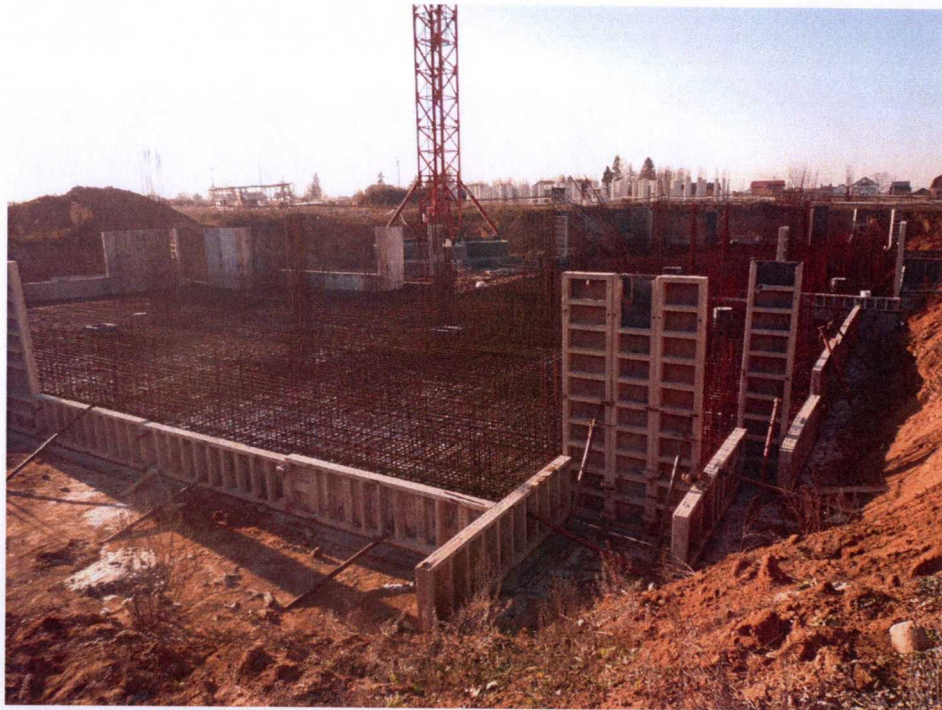
Фото № 5. Общий вид смонтированных секций 1,2
