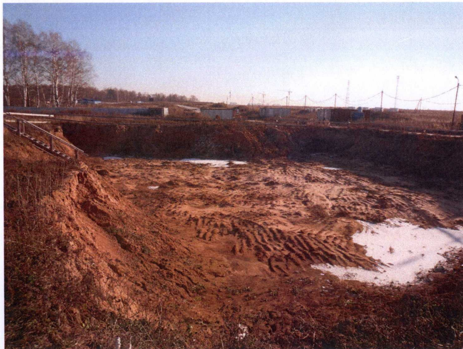
Фото № 7. Котлован для строительства секции 6
