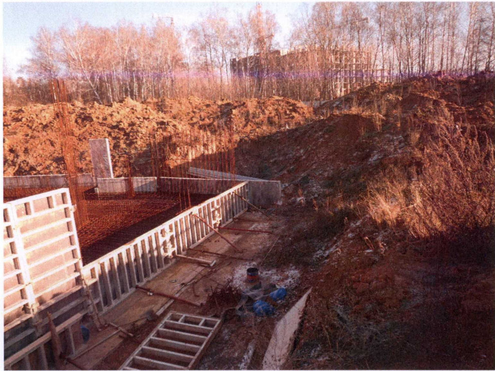
Фото № 3. Вид на секцию 2 со стороны секции 3
